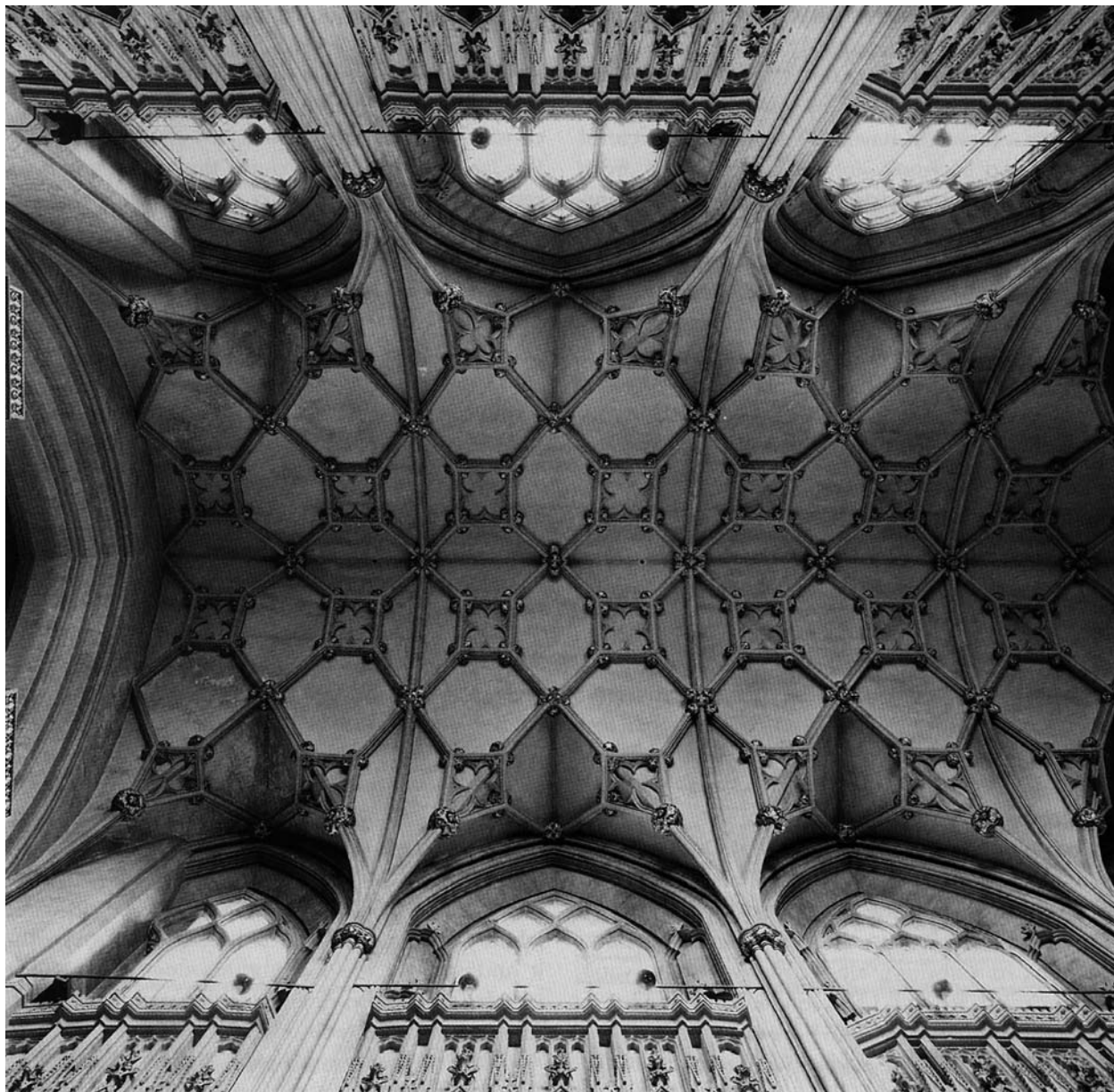
Obr. 10: Wells. Katedrála. Klenba střední části chóru: CROSSLEY, P.: Peter Parler and England – a problem re-visited . In: STROBEL, R. – SIEFERT, A. – HERRMANN, K. J.: Parlerbauten. Architektur, Skulptur, Restaurierung . Stuttgart 2004, s. 162. Repra.
